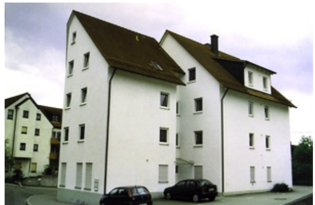
Wohn- und Geschäftshaus in Krumbach
