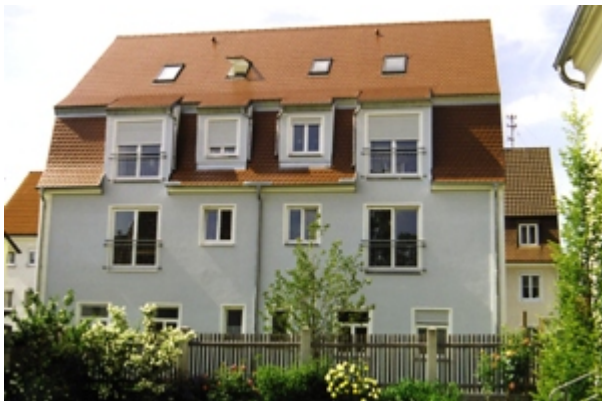
Wohn- und Geschäftshaus in Krumbach
